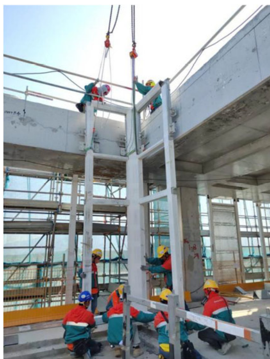
圖2 構件式玻璃幕牆安裝
