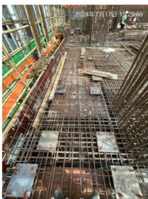
圖7完成釘板及紮鐵工序
