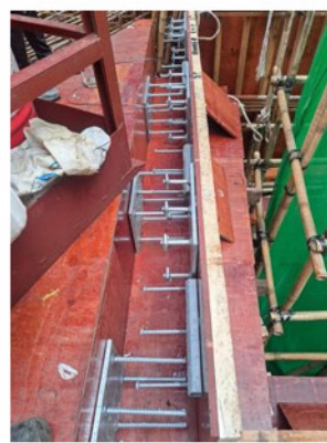
圖9將預留碼固定在木板
