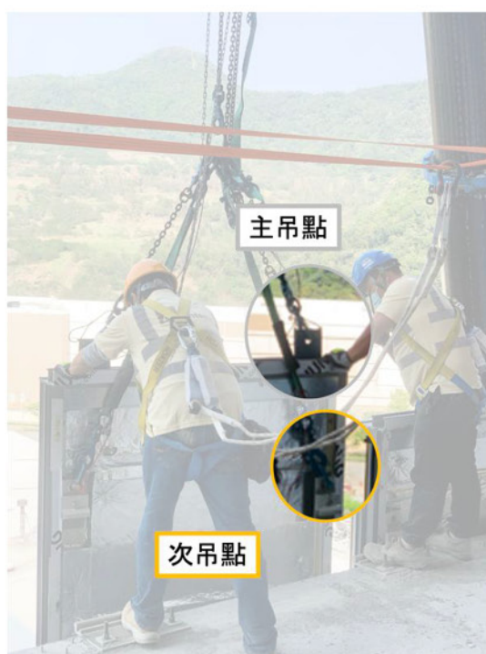
圖20主吊點與次吊點
