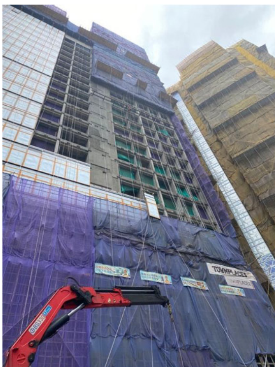
圖1 單元式玻璃幕牆安裝
